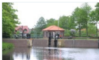
Die sanierte Emsschleuse am Haren-Rütenbrock-Kanal
